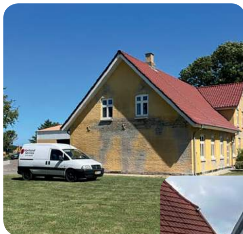
Oppudsning af facade
