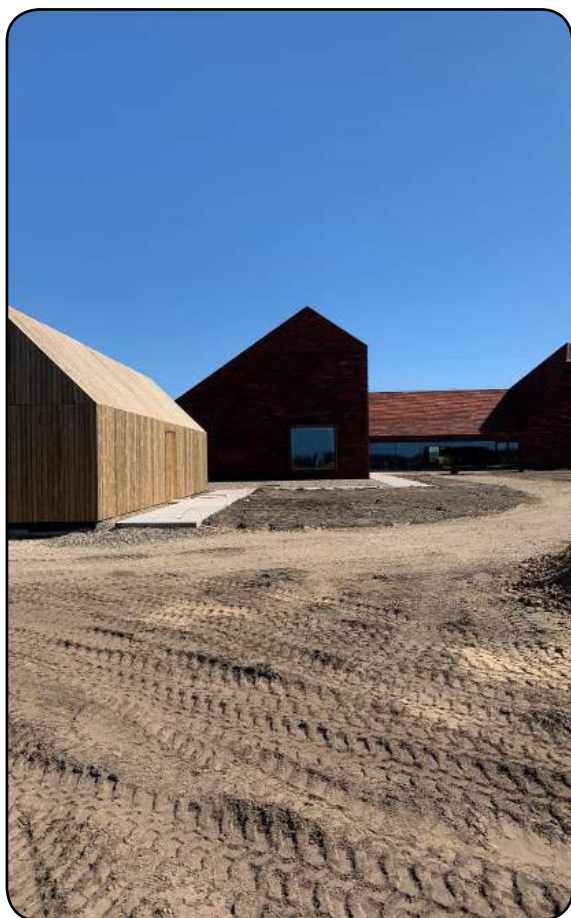
Vue fra vest. Der arbejdes PT med færdiggørelse af området omkring Kornets Hus. Det nybyggede skur ses til venstre. Foto: Bente Føns Nielsen
