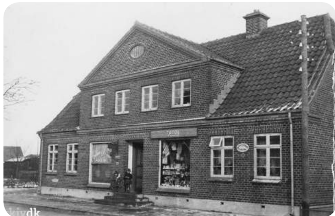
Forretningsbygningen Hovedgaden 54 Poulstrup. 3 forretninger på samme tid og sted: Damefrisør, Vin & tobak, Sæbeforretningen "Tato!" Tidsperiode ca. 1940-1960 - senere blev bygningen lavet om til lejligheder, og undertegnede er faktisk født på første sal i 1966
