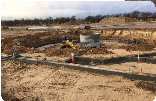
Malkekarussellen bliver støbt som noget af det første
