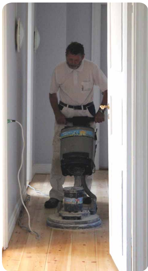
Gulve i gang og køkken er blevet slebet
