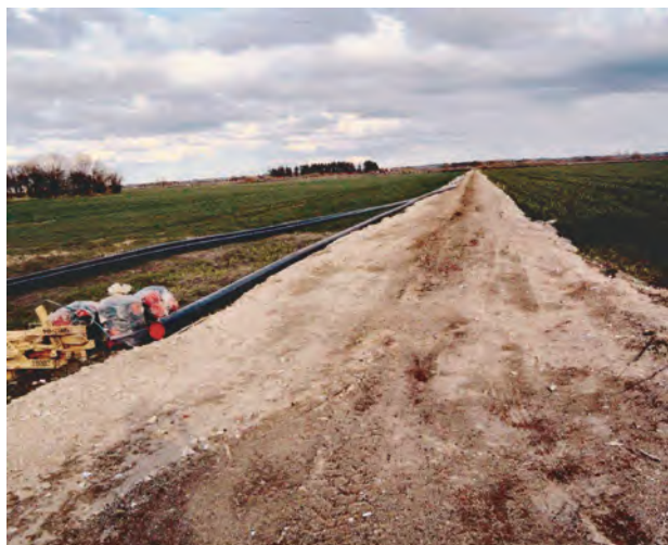
De sammensvajsede rør på den nyanlagte vej - lige syd for Rimmensholm i Guldager
