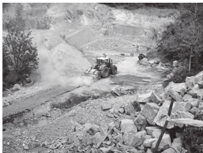
Stenknuseren i gang med at knuse asfaltbelægning.
