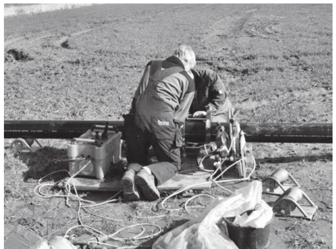
I færd med at svejse rørene sammen
