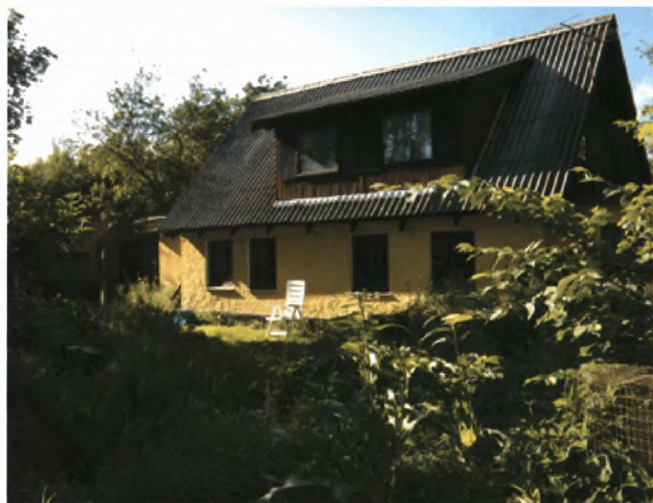
Søvangsvej 31 som det så ud før nedrivning.
