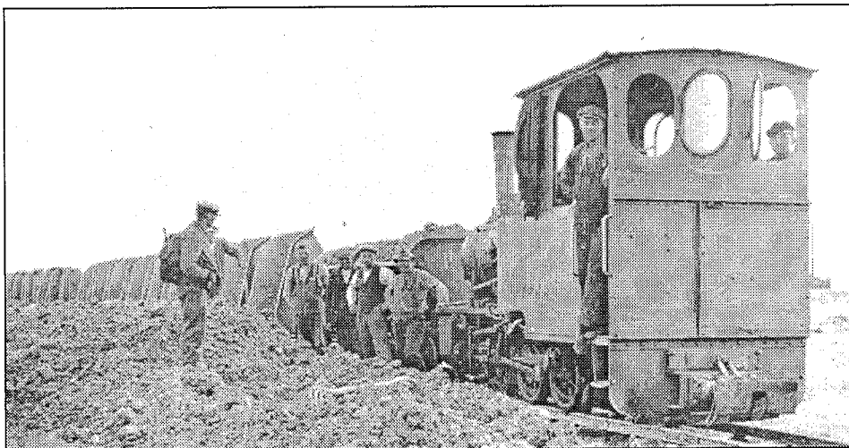
Aflæsning af mergel fra tipvognstog ved mergellejet ved Guldager.
