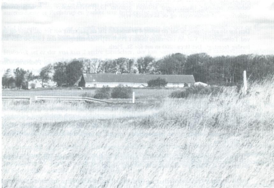
Motorvejens linieføring mod nord fra Tollestrupvej. I baggrunden St. Pleth
