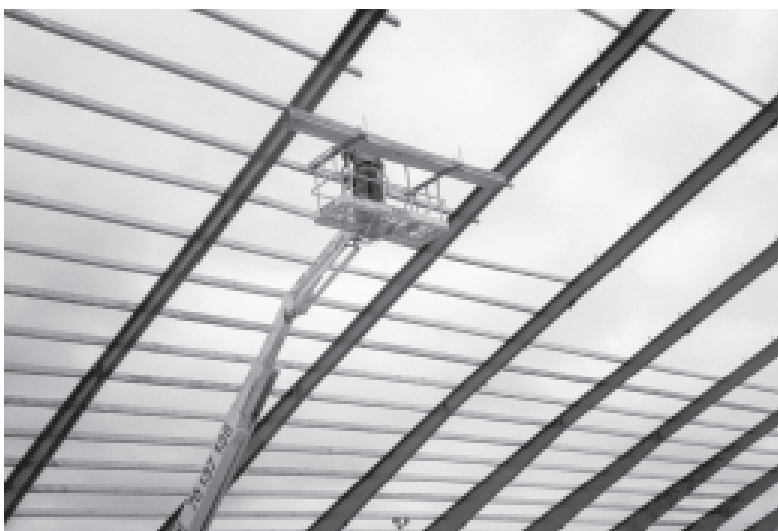
Opstilling af buer og åser (Lægter)
