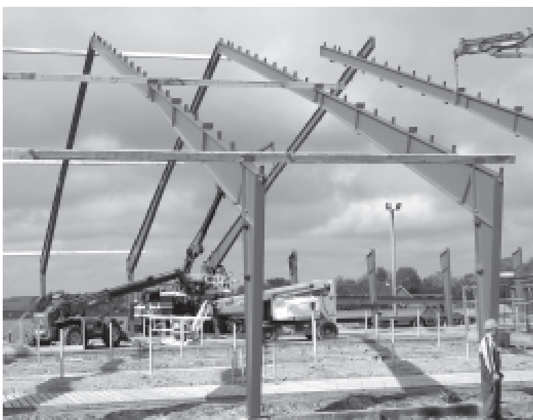
Opstilling af buer og åser (Lægter)
